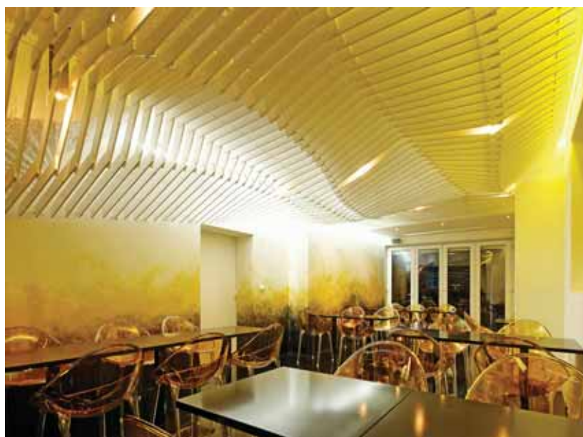
Podhled byl navržen metodou parametrického designu a jedná se o první realizaci digitální architektury u nás
