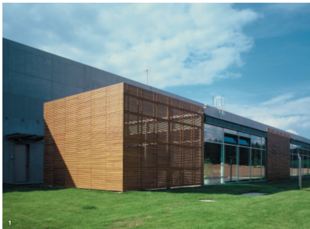
Výrobní areál firmy Hranipex, Komorovice
