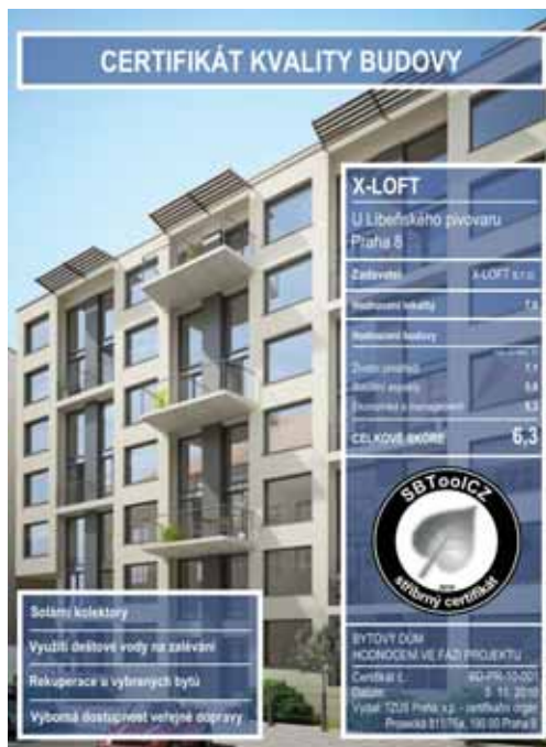
První certifikovaná budova SBToolCZ – x-loft (zdroj: www.x-loft.cz )
