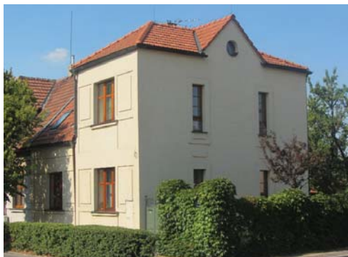
Stavba se nachází na Kladně (nadmořská výška 410 m. n. m.) a je řešena jako dvojdoměk
